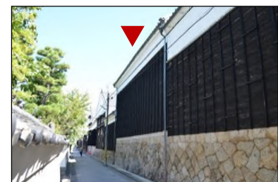
図2-5-23 米蔵 (明治7年(1874)建築)
