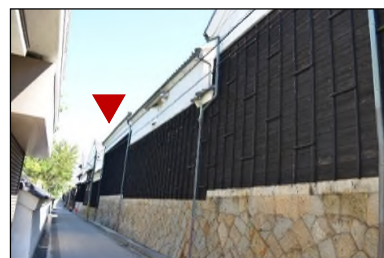
図2-5-22 乾蔵 (明治7年(1874)建築)
