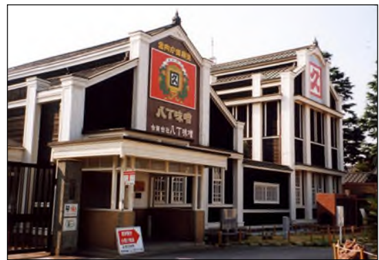
図2-5-15 カクキュー本社事務所
