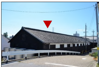
図2-5-18 新甲子蔵 (昭和14年(1939)建築)
